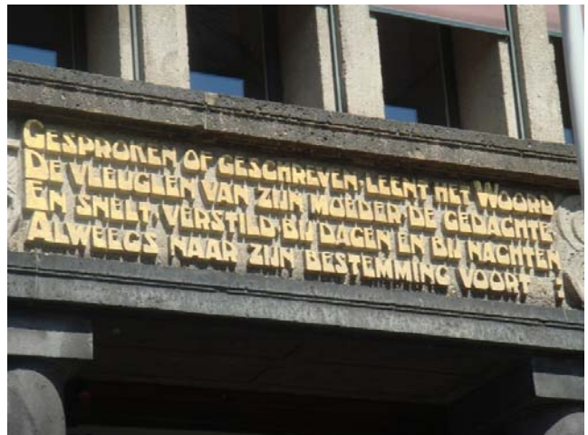
Voormalig PTT-gebouw, Kortenaerkade
