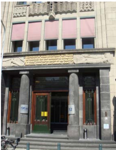
Voormalig PTT-gebouw, Kortenaerkade
